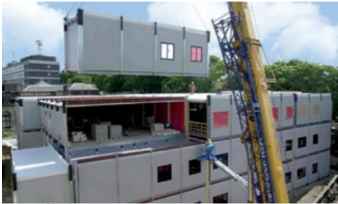
تركيب الوحدات الجاهزة مفتوحة الجوانب في مستشفى
