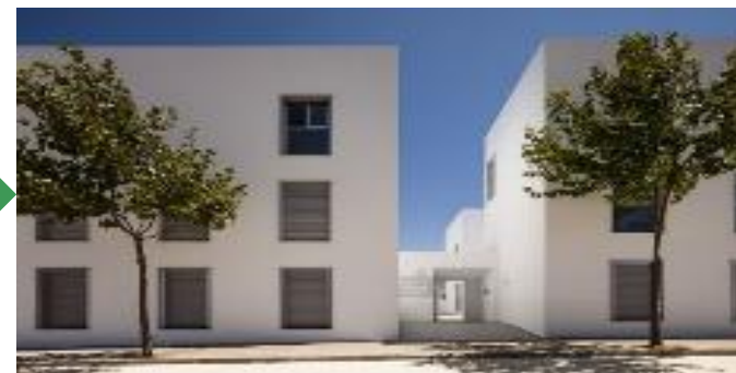
6 توصيل جميع وحدات البناء الجاهزة وتسليم الوحدة
