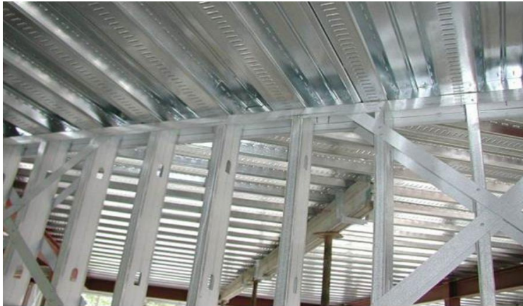
الربط بين جدران الحديد الخفيف وبلاطة الأرضية
