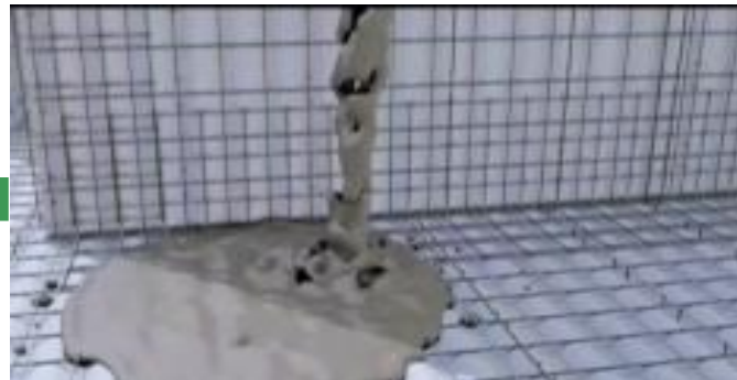
2 صب مزيج الخرسانة على وحدة البناء الجاهزة
