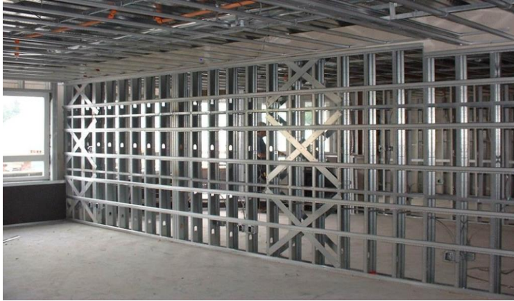
إعداد هيكل الحديد خفيف الوزن قبل تركيب الصفائح
